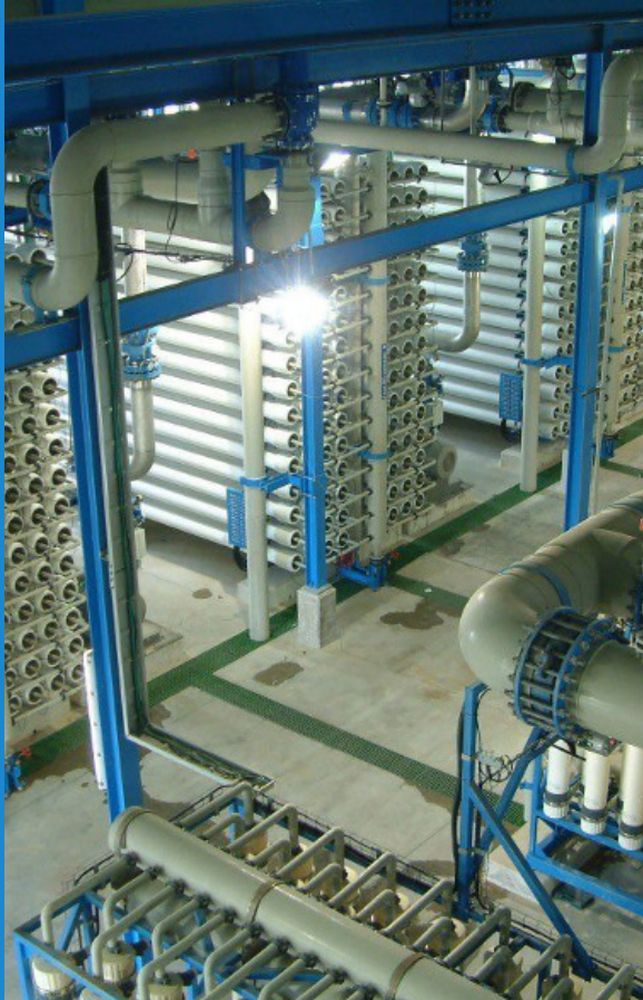
معدات التناضح العكسي داخل محطة لتحلية المياه المالحة، المؤسسة العامة لتحلية المياه المالحة
