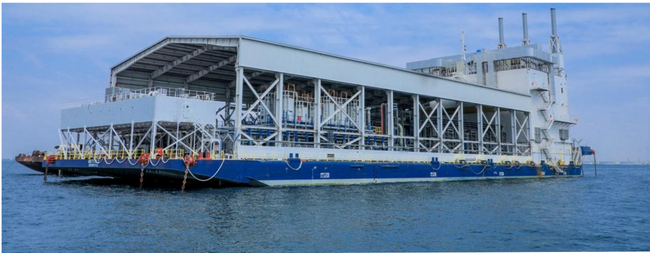
محطة عائمة لتحلية المياه المالحة، المؤسسة العامة لتحلية المياه المالحة
